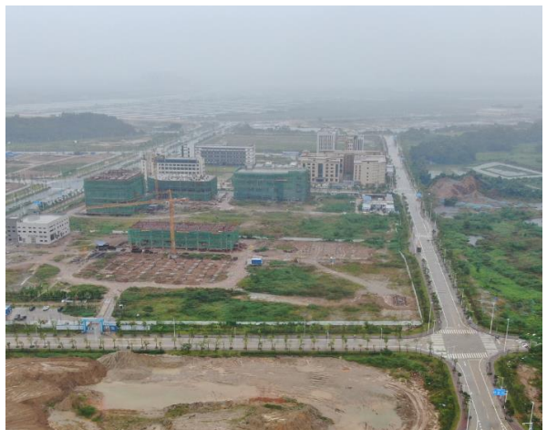
道路完工现状
