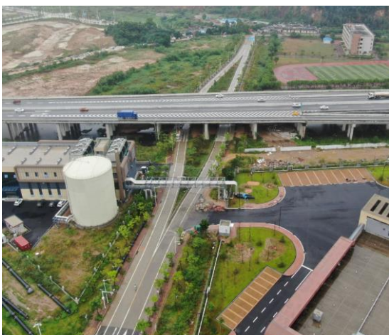
道路完工现状
