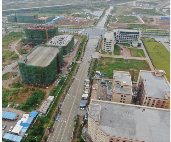
道路完工现状
