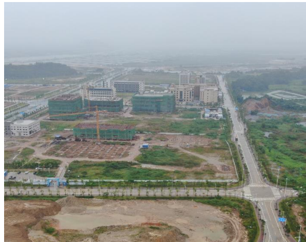
道路完工现状
