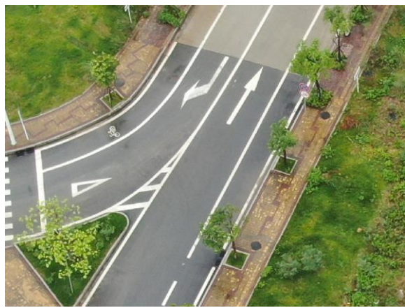
道路完工现状
