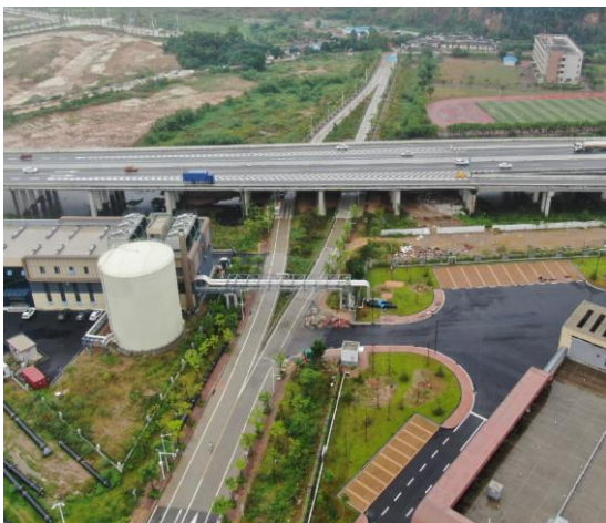
道路完工现状
